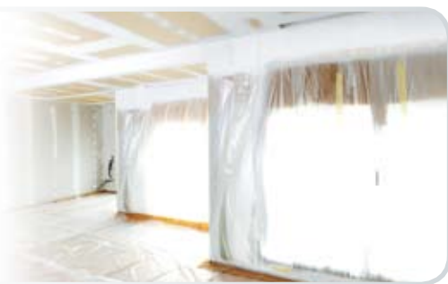
Preparación de la obra Preparação da obra
