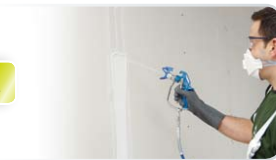
Realizar un tratamiento Q2 en las juntas Efetuar um tratamento Q2 nas juntas
