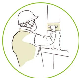
Rellene la junta con pasta de juntas Pladur® y a continuación coloque la cinta de juntas Pladur® de forma que su cara reverso apoye sobre la pasta y quede centrada. Retire el exceso de pasta presionando ligeramente con una espátula y evitando dejar burbujas de aire y grumos bajo la cinta. Deje secar por completo y aplique las manos de pasta necesarias según el nivel de acabado que desee conseguir.
