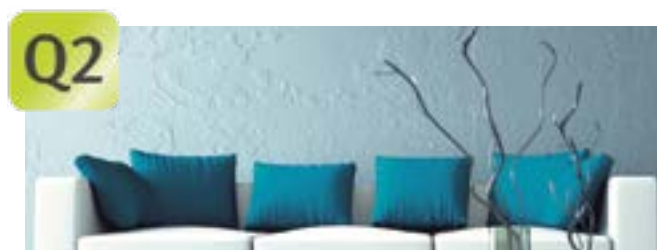
Q2 Cette finition assure une transition continue sur tout le parement, bien que n'évitant pas l'éventuelle apparition de spectres, en particulier sous une lumière rasante. Elle est indiquée pour les finitions moyennes ou grossières, d'une granulométrie supérieure à 1 mm.
